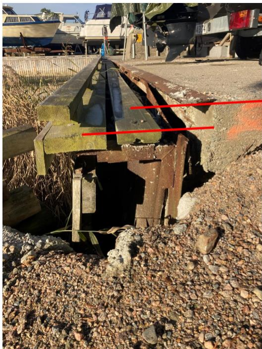
Figur 1 Setningsskader bryggefront (bildet er tatt høsten 2021)
